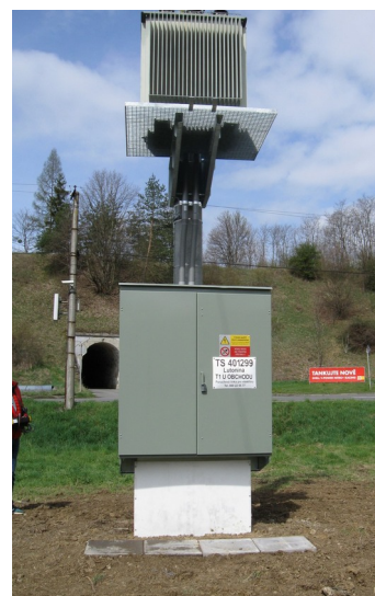
I z tohoto transformátoru s rozvaděčem, na kraji vesnice, se vložením chytré krabičky a připojením k internetu může stát uzel chytré sítě
