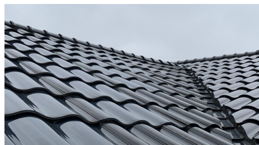
Solární panel může vypadat jako běžná krytina
